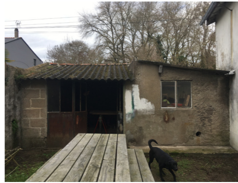
Façade existante de l'atelier
