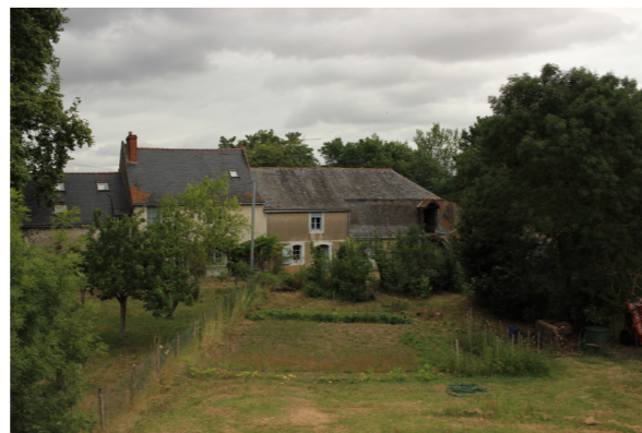
Vue de la maison depuis la digue
