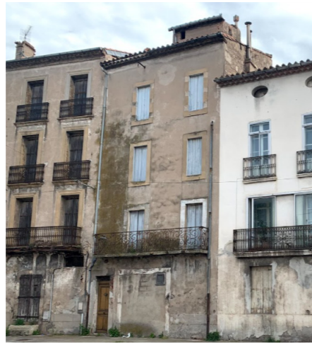
Un patrimoine bâti détérioré.
